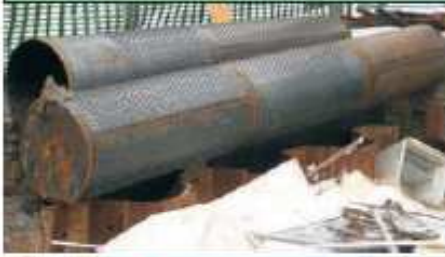
PARADISO - Hotel Conca d'oro Esecuzione pozzi drenanti per abbassamento falda freatica
