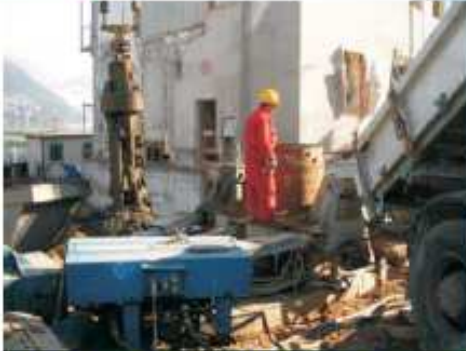
PARADISO - Hotel Conca d'oro Esecuzione pozzi drenanti per abbassamento falda freatica
